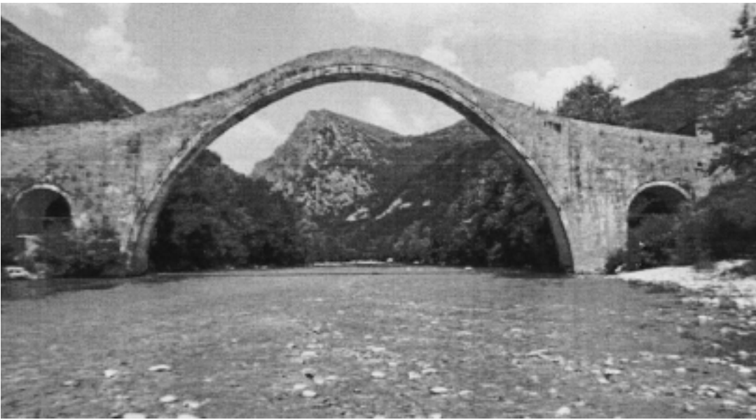
Το γεφύρι της Πλάκας, πριν από την καταστροφή του στις 2 Φλεβάρη 2015...
